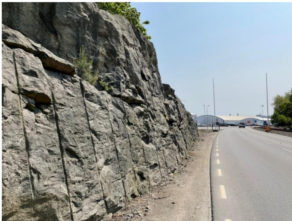
Figur 18. Bergskärning i det södra området mot sydväst.
