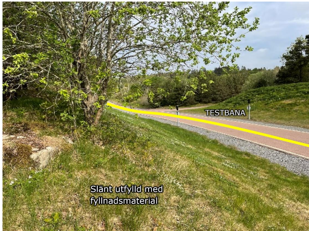
Figur 17. Jordtäckt uppfylld slänt söder om demonstrationsbanan. Berg i dagen syns i släntens överdel.
